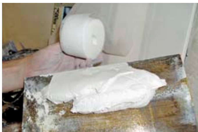
So nicht: Nach dem Applizieren des Glasvlieses darf nicht sofort überglättet werden.
