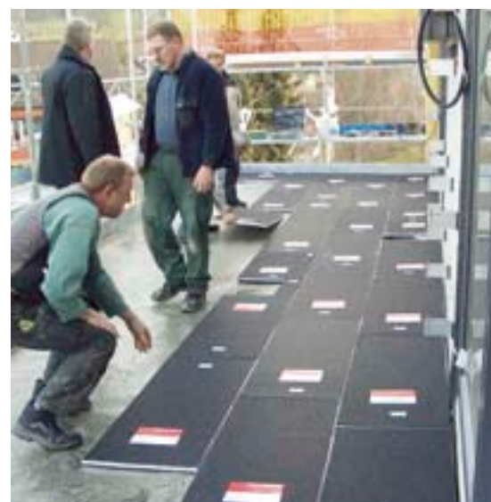
Vakuum-Dämmplatten werden seit Jahren erfolgreich bei der energieeffizienten und gleichzeitig dünn-schichtigen Terrassenisolation eingesetzt. (Bild: ZZwancor AG)
