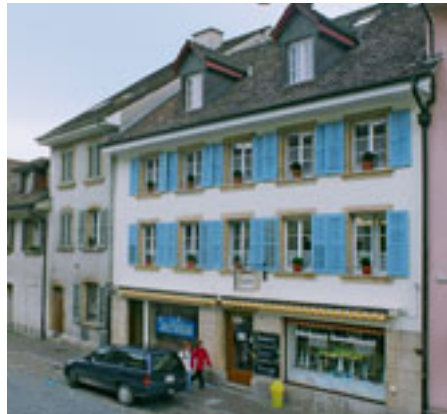
Die bereits renovierte Fassade über der Bäckerei «Stedtlibeck» in Erlach.
