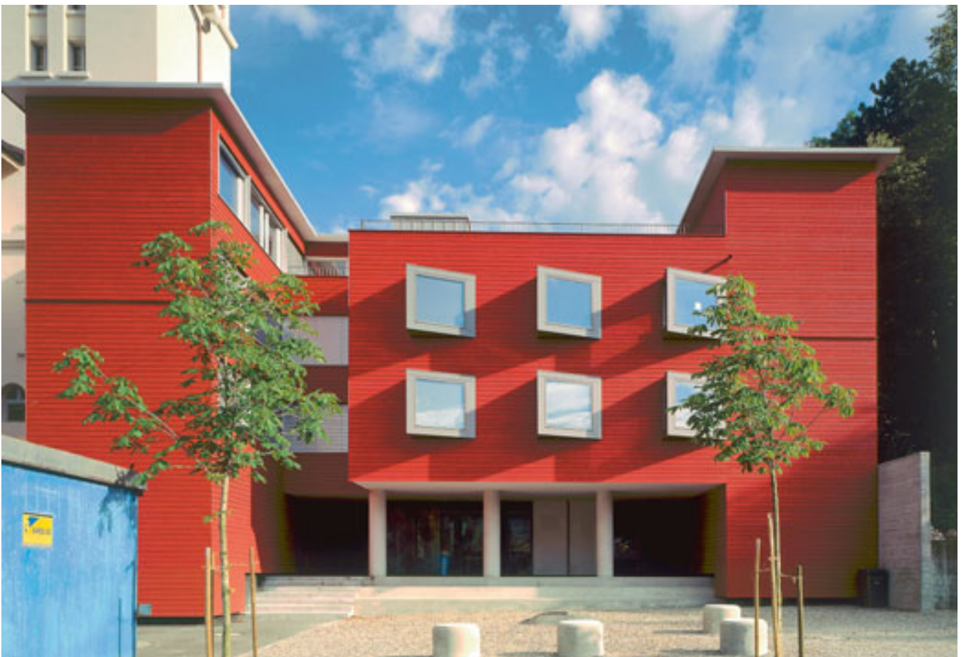
Das von den Architekten Herbert und Roman Oberholzer 1997 entworfene Internat in Immensee springt mit seiner rötlich lasierten Holzoberfläche ins Auge. (Bild: Hans Enge, Luzern/Lignum)
