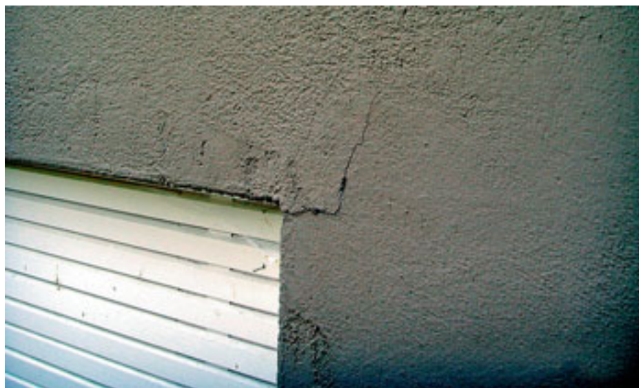
5 Bei mineralisch gebundenen Glattputzen mit einer Körnung von < 0,5 mm ist ein Augenmerk auf das erhöhte Rissrisiko zu richten. Risse mit einer Breite von < 0,1 mm sind zu tolerieren, wenn diese nicht zu Folgeschäden führen.
