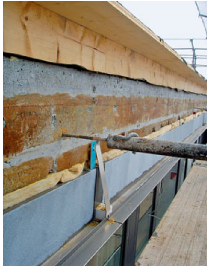
9 Eine schier unlösliche Aufgabe stellt dieser zu beplankende Traggrund dar, der aus verschiedenen Materialien mit unterschiedlichen Ausdehnungskoeffizienten besteht. Die Norm SIA 243 fordert deshalb, dass Tragkonstruktionen im Dachrandbereich, welche aus Holz oder Metall erstellt wurden, bezüglich thermisch bedingter Verformbarkeit oder bezüglich der Verformung infolge Feuchtigkeit beurteilt werden müssen.
