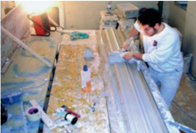
Lehrling Rocco Zullino zieht die Stuckprofile für die denkmalgeschützte Decke.
