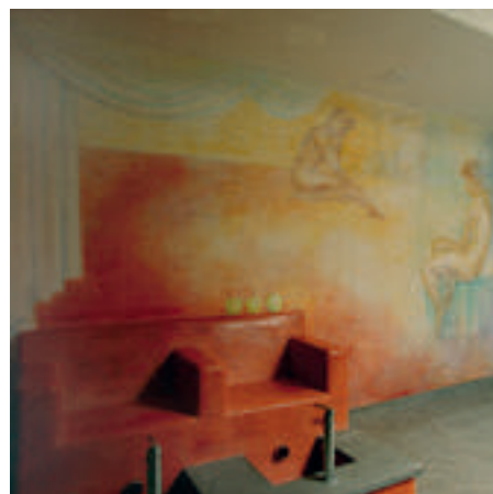
6 Auch organische Untergründe im Innenraum, wie in diesem Wellnessbereich, lassen sich mit einer Sol-Silikatfarbe sanieren und danach beispielsweise schön lasieren.
