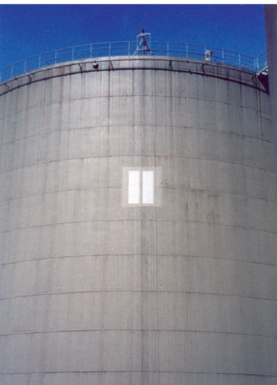
5 Repräsentative Musterfelder an einem Stehtank.
