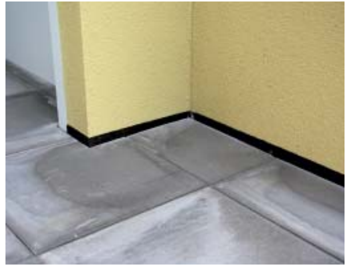
3 Die Zementplatten wurden nicht bis auf das verlangte Niveau geführt. Die bituminöse Schutzbeschichtung kann sich deshalb in der Sonne erwärmen und vom Putz ablösen. Auch wird der Putz bei Bewitterung oben durchfeuchtet, und es kann zu einer Hinterwanderung der Schwarzbeschichtung kommen.
