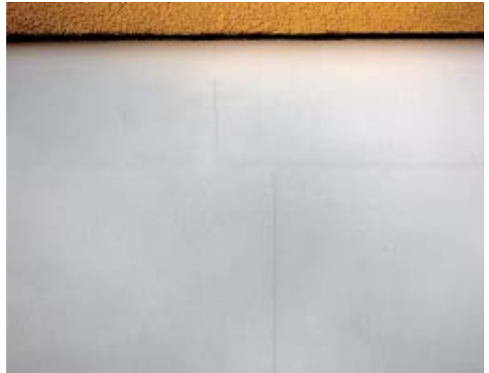
9 Im Sockelbereich wurde eine XPS-Platte verwendet, um dadurch eine schlagfestere AWD zu erreichen (links). Als Folge der falschen Anwendung der XPS-Platte mehr als 25 cm oberhalb der Sockellinie bildeten sich innerhalb von etwa zwei Jahren Risse im Bereich der Plattenstösse (rechts).
