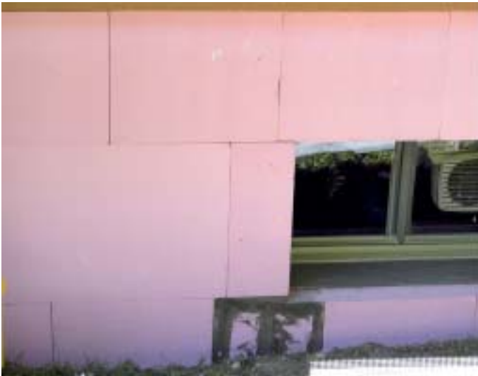
9 Im Sockelbereich wurde eine XPS-Platte verwendet, um dadurch eine schlagfestere AWD zu erreichen (links). Als Folge der falschen Anwendung der XPS-Platte mehr als 25 cm oberhalb der Sockellinie bildeten sich innerhalb von etwa zwei Jahren Risse im Bereich der Plattenstösse (rechts).
