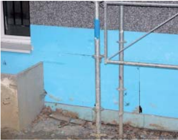
2 Im Sockelbereich wurden die XPS-Platten weit über die Sockellinie geführt. Als Bezugspunkt für die richtige Höhe der Sockellinie kann der Lichtschacht gewählt werden.
