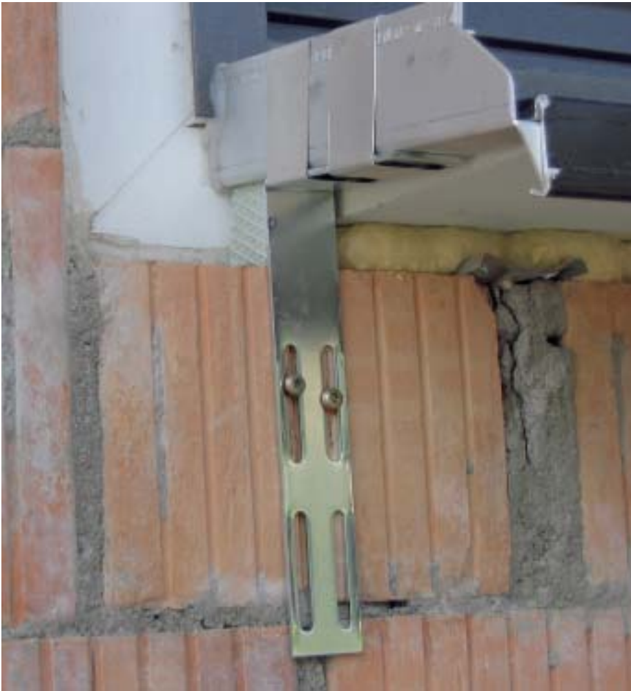
6 Spezielle Tragkonstruktion für eine Fensterbank.
