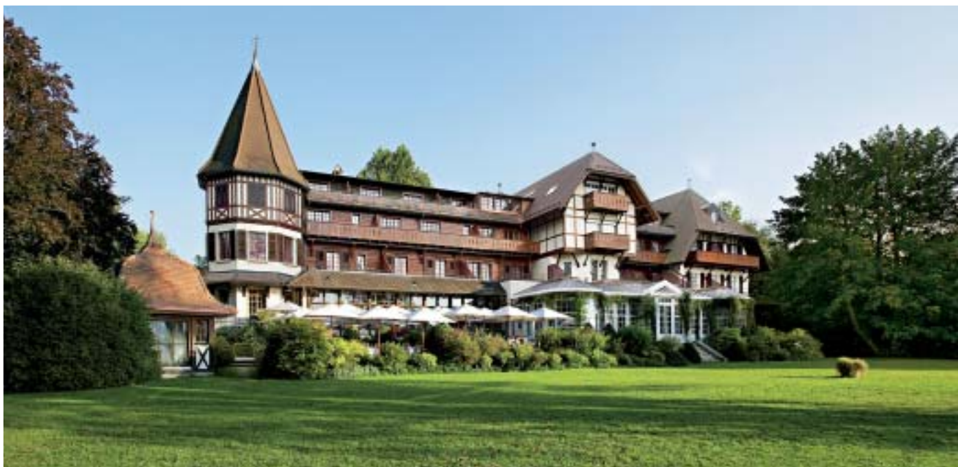
Das Hotel Le Vieux Manoir in Murten wurde umfassend renoviert. Links die Volière, die zum «kleinsten Restaurant der Schweiz» – mit nur zwei Plätzen – umgebaut wurde.
