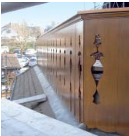
Die Behandlung der Holzteile der Fassade geschah an drei verschiedenen Orten. Trotzdem sind keine Unterschiede in der Farbtönung zu sehen.
