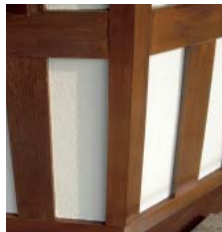
Die Behandlung der Holzteile der Fassade geschah an drei verschiedenen Orten. Trotzdem sind keine Unterschiede in der Farbtönung zu sehen.
