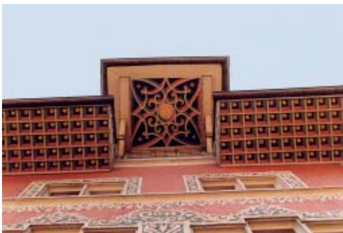
Haus an der Rathausgasse 22 mit einer frühbarocken Sgraffitodekoration mit der Jahreszahl 1641 an der Fassade, darüber ein «moderner» Dachhimmel mit Blumen und Sternen in einem Rastersystem, dazwischen eine reich verzierte Sonne.
