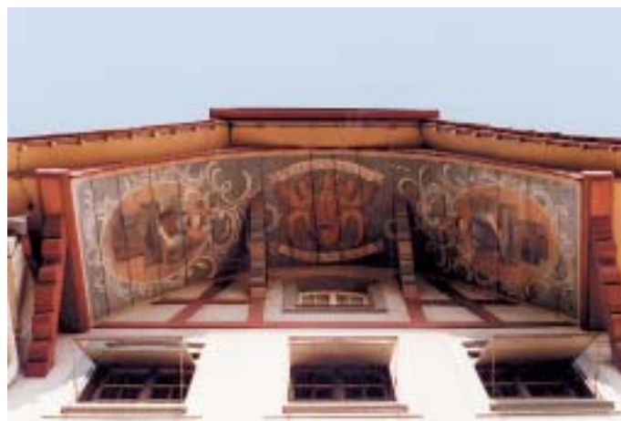
Die Malerei dieses Dachhimmels weist auf den Zweck des Hauses – eine Messerschmiede – hin (Vordere Vorstadt 29).
