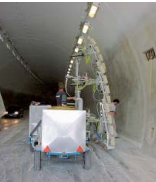
Für die Beschichtung von Tunnelwänden hat Christian Dietrich einen Roboter konstruiert.
