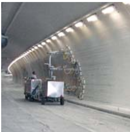
Mit dem Beschichtungsroboter Mirus war im Girsberg-Tunnel in Kreuzlingen in zehn Tagen die ganze Fläche von 70'000 m 2 gespritzt.
