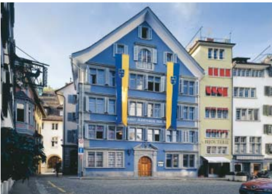
Das Zunfthaus zur Waag am Münsterhof in Zürich wurde grundlegend renoviert und präsentiert sich in einem neuen, blauen Kleid. (Foto: Beat Soller)
