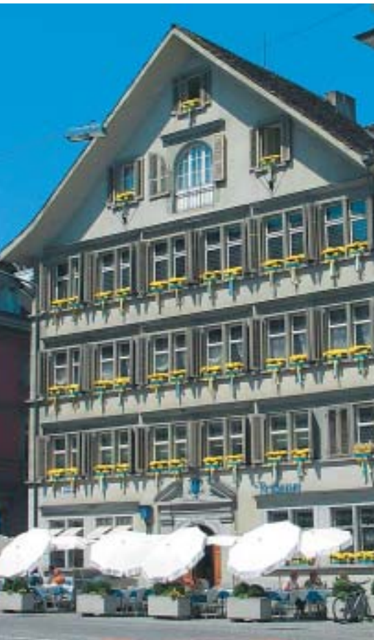
Vor der Renovation von 2004 zeigte sich das Zunfthaus in einer unauffälligen, hellen Farbgebung. (Foto: Beat Soller)
