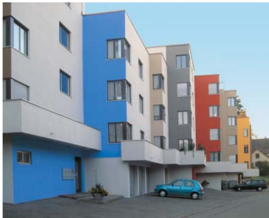
3 Bei diesen Eigentumswohnungen an der Püntstrasse in Horgen wurden bei der Renovation im Jahr 2003 nur die östlichen Fassadenvorsprünge farblich akzentuiert. (Foto: Walter Suter, Horgen)
