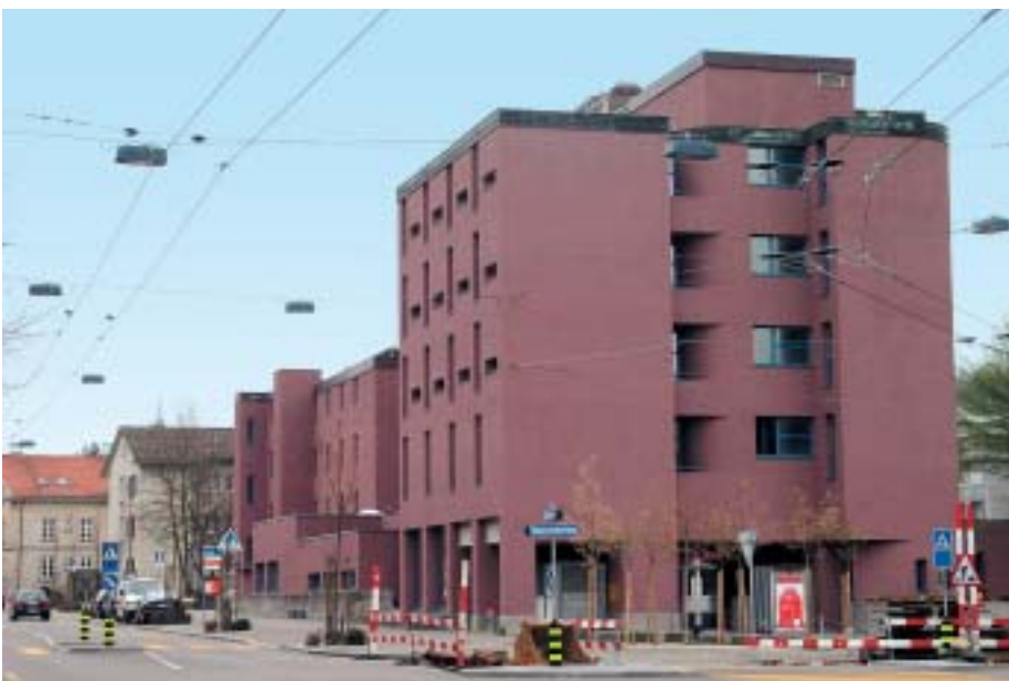
1 Eine gelungene Fassadengestaltung ist nicht einfach bunt, sondern basiert auf einem Konzept. Hier die 1964–66 von Ernst Gisel erbaute Jugendherberge in Zürich-Wollishofen, die 2003–04 renoviert wurde.
