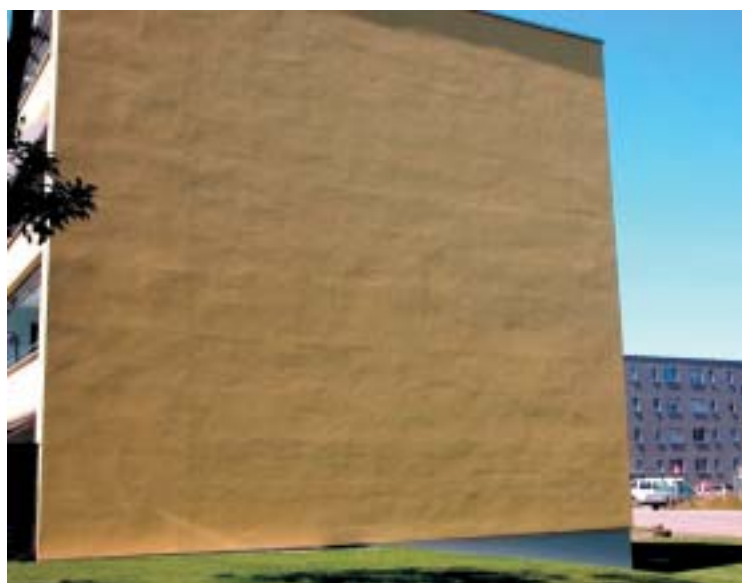
5 Im Streiflicht treten wellenförmige Abzeichnungen bei praktisch allen verputzten Aussenwärmedämmsystemen und allen konventionell verputzten Fassadenflächen auf und müssen normalerweise akzeptiert werden.
