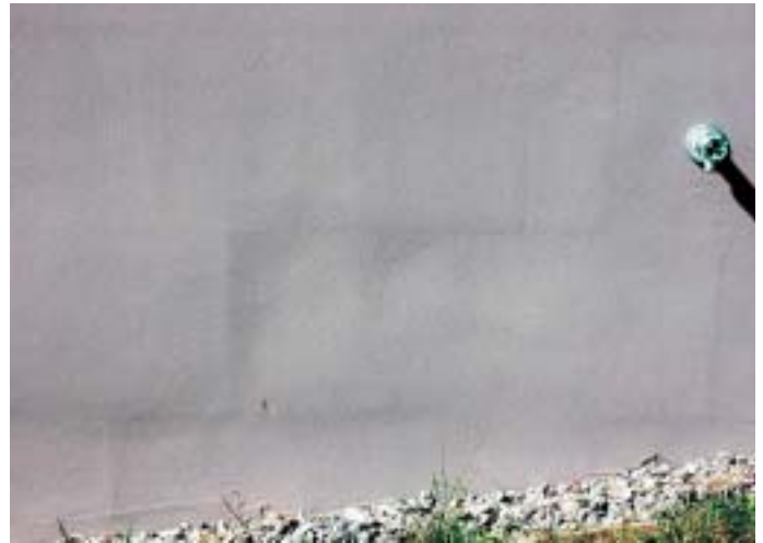
2 Abzeichnungen im Sockelbereich infolge zu hoch geführter XPS-Platten sowie des verwendeten bituminösen Klebemörtels.
