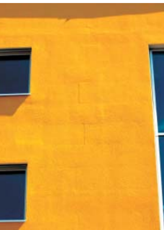
3 Abzeichnung der klaren Konturen einzelner Wärmedämmplatten.
