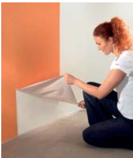
Bei Renovationen können Vliestapeten einfach trocken abgezogen werden.
