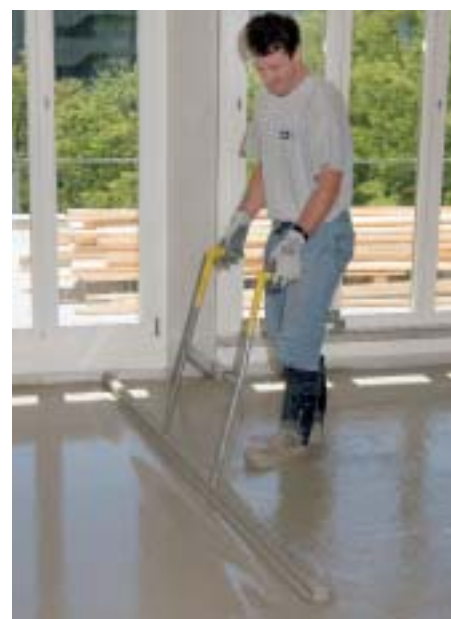
Der gegossene Calciumsulfat-Fliessestrich wird mit Hilfe einer Schwabbellatte bewegt und ausnivelliert.
