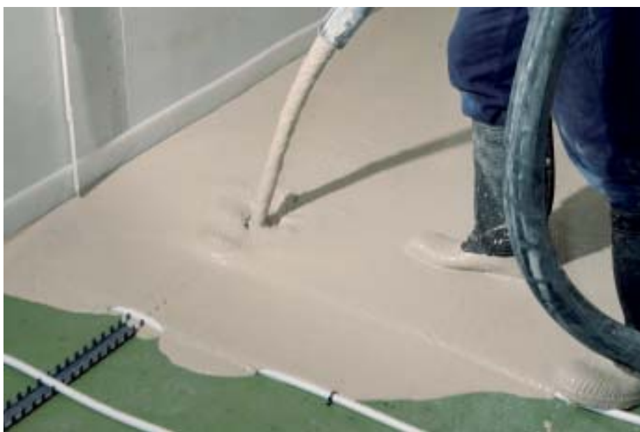
Eingiessen des Calciumsulfat-Fliessestrichs auf die dicht abgeklebte Trennschicht über der Dämmschicht.
