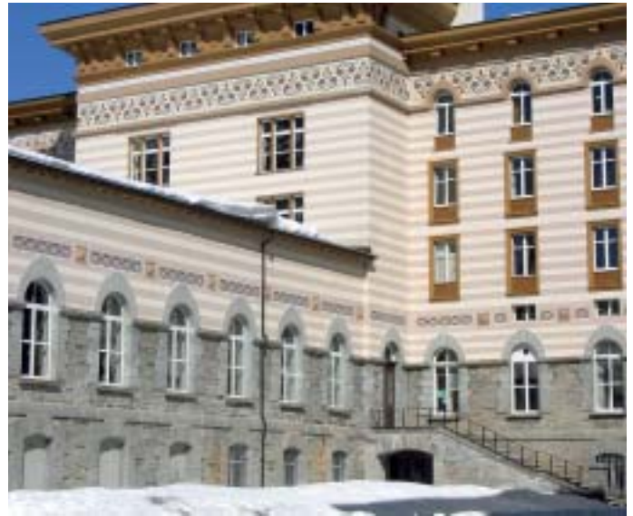
Zwischen der Teilrenovation von 1994 (linker Gebäudeteil) und der Renovation von 2004 ist trotz zehn Jahren Zeitdifferenz praktisch kein Unterschied zu sehen.
