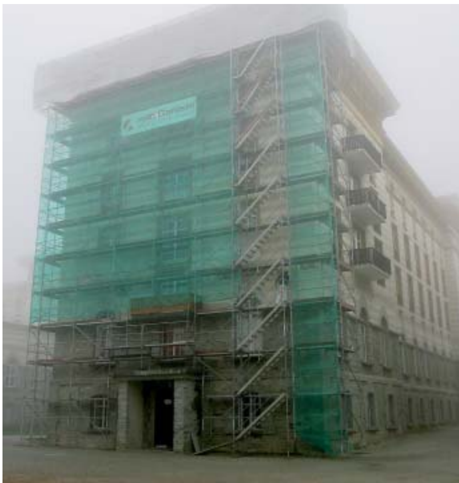
Eckrisalit im Malojanebel. Die Feuchtebelastung der Fassaden ist in dieser Region wegen des starken Windes gross.
