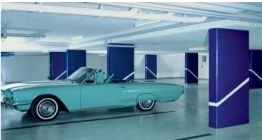
Für Boden- und Wandversiegelungen wie hier in einer Tiefgarage haben sich wasserverdünnbare Zweikomponenten-Epoxidharzversiegelungen bewährt.
