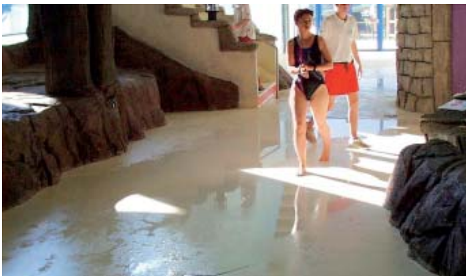
Stürze durch Ausgleiten können durch gute Bodenfarben vermieden werden. Wichtig ist dies vor allem in Bereichen, wo der Boden nass sein kann.
