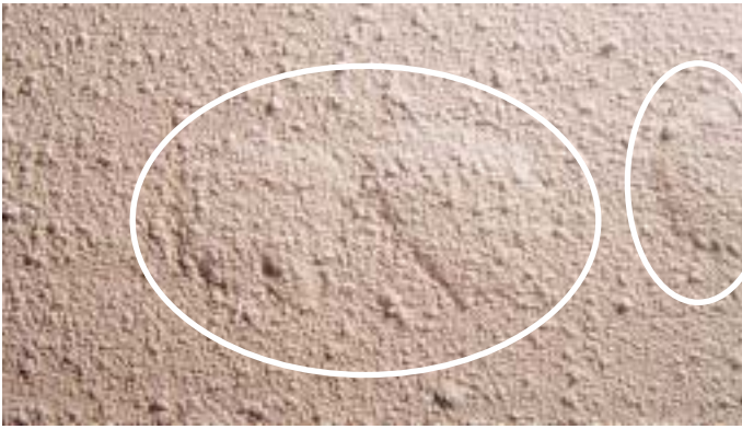
Pusteln im Weissputz können durch eine Indikatorflüssigkeit besser sichtbar gemacht werden.
