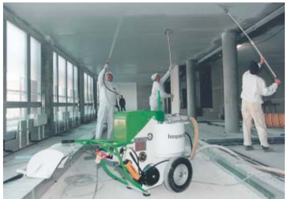
Durch den Einsatz von Spritzgeräten bei der Applikation von pastösen Spritzspachteln lassen sich sowohl die Rüst- als auch die Auftragszeit markant reduzieren.
