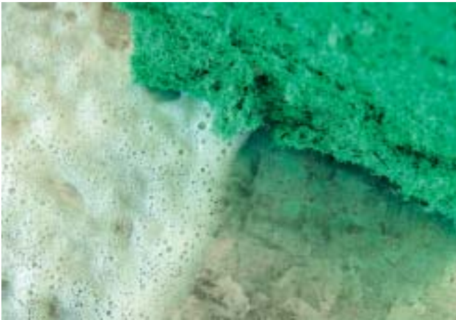
Die ammoniakalische Netzmittelwäsche ist für verzinkte Untergründe die geeignete Vorbereitung vor dem Aufbringen von Anstrichen.
