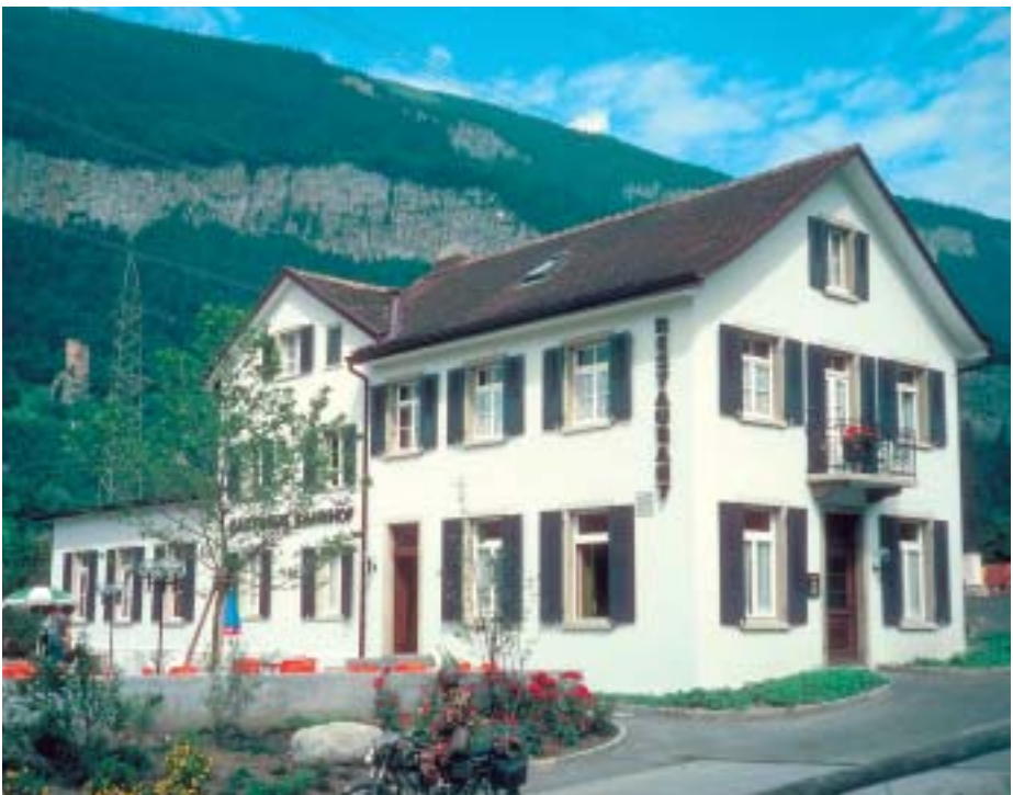
Das Restaurant Bahnhof in Haldenstein, 1982 mit Silikonfarbe gestrichen. (Aufnahme von 1999)
