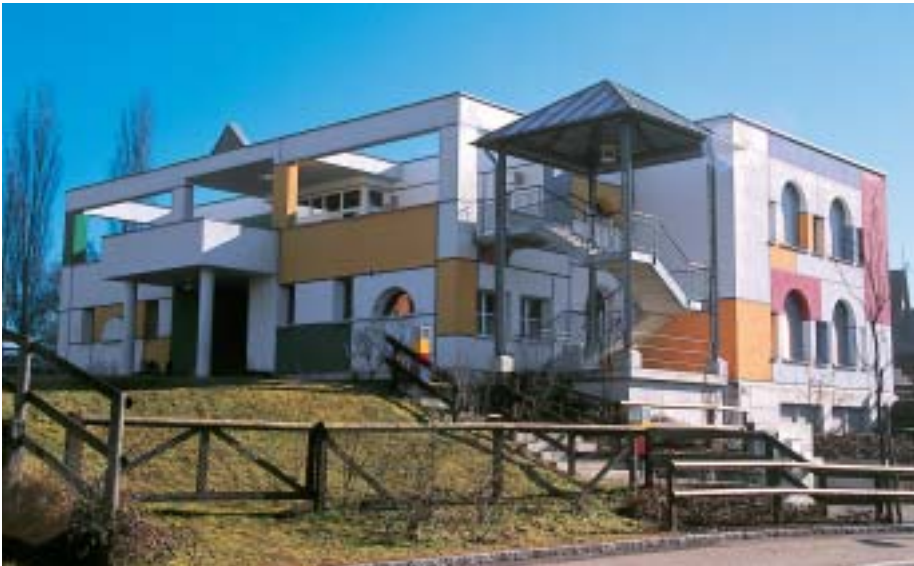
Modern gestaltetes Gebäude in Winterthur. Silikonanstrich von 1994, Aufnahme von 1997.
