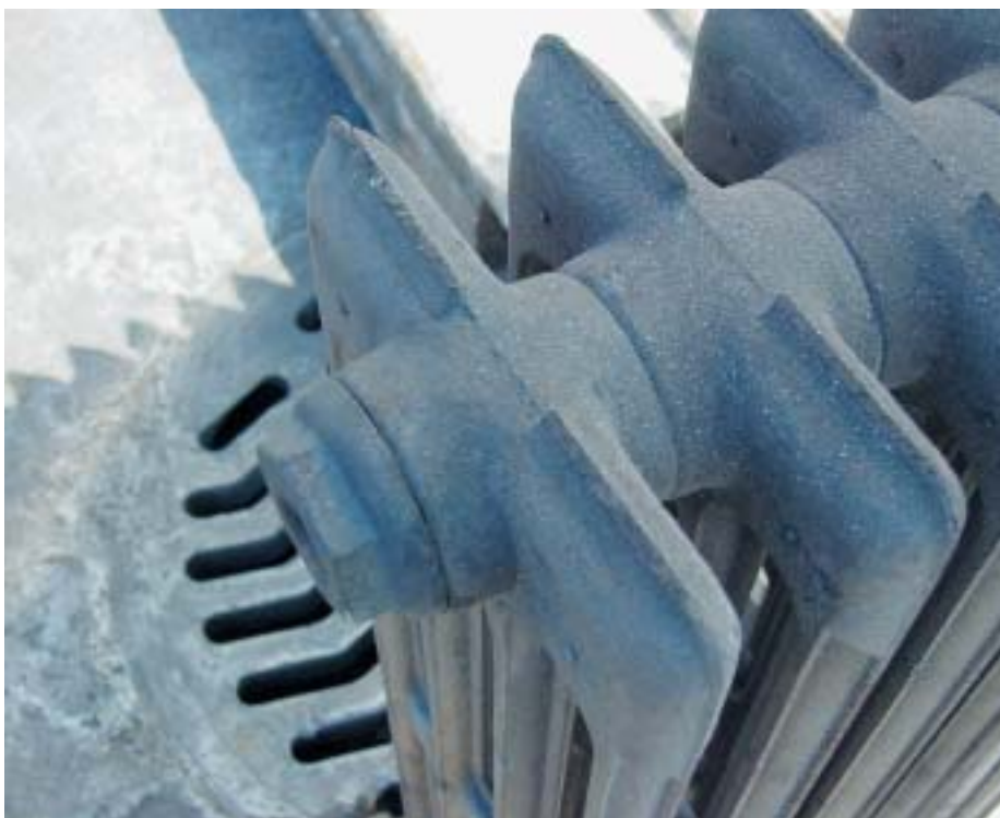
Eine Passivierung schützt den Gussheizkörper nach der porentiefen Entlackung vor Flugrost.
