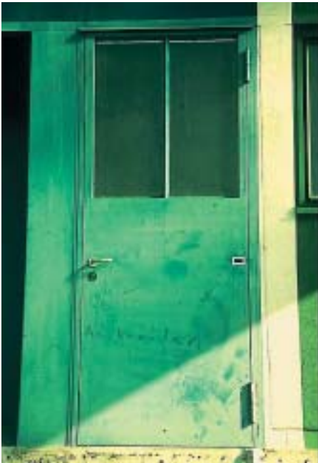
Kreidung auf einer blauen Metalltüre. Grüne und blaue organische Pigmente neigen in der Aufhellung mit Titandioxid zu extremem Kreiden.
