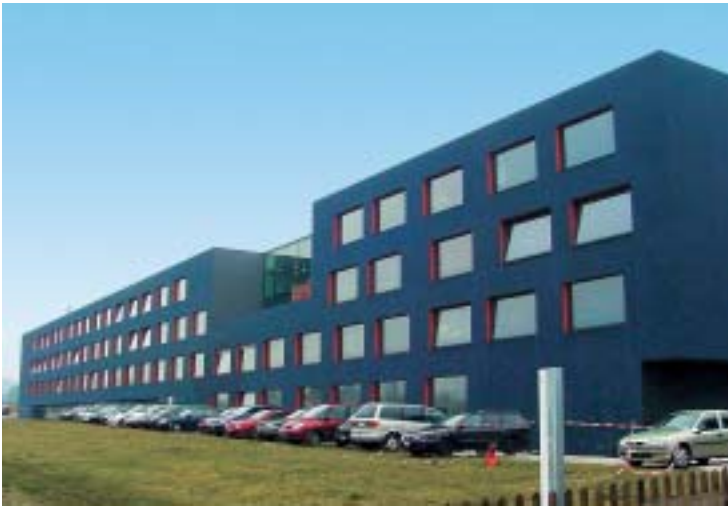
Moderne Fassadengestaltung mit Eisenoxidschwarz und Kobaltblau. Auf den Einsatz von Titandioxid wurde verzichtet, um die Kreidung gering zu halten.
