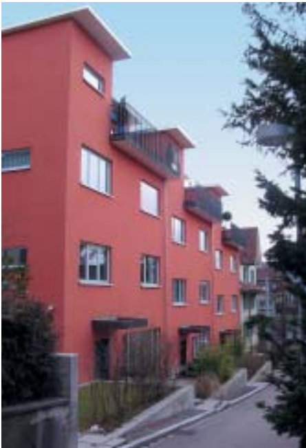
Neubaufassade mit einer auf Eisenoxidpigmenten basierenden Farbe.
