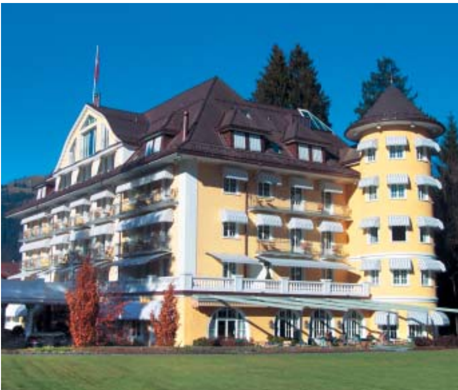
Das Grandhotel Bellevue in Gstaad wurde gesamthaft erneuert. Trotz des Aufbaus zweier seitlicher Türme ist der alte Charakter des Äusseren erhalten geblieben.
