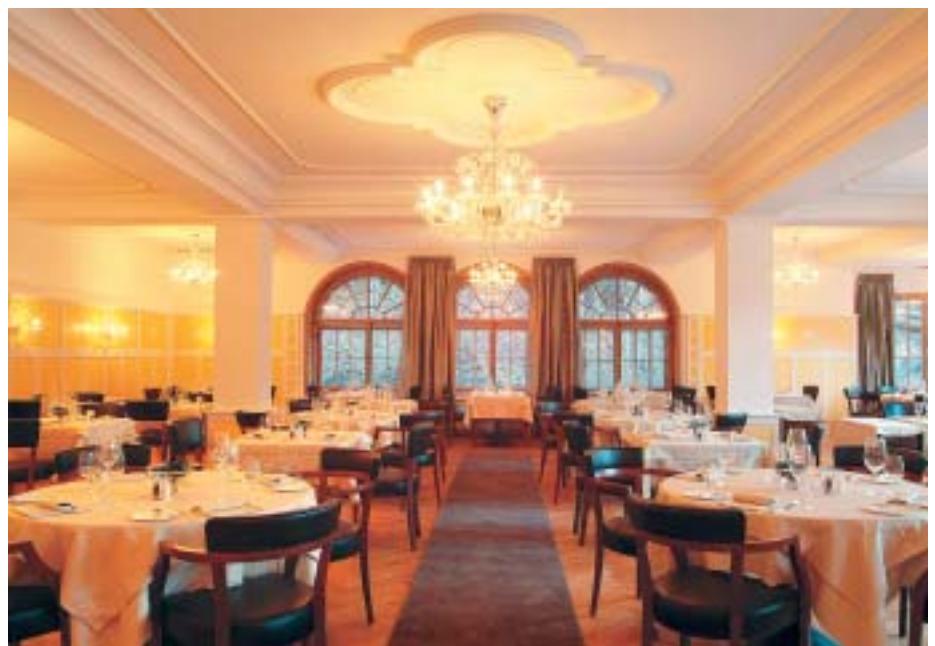
Im Restaurant Coelho schmückt eine grosse Vierpassrosette die Decke, umrahmt von verschiedenen breiten Stuckstäben. An den Wänden finden sich Felder in Stucco Veneziano.
