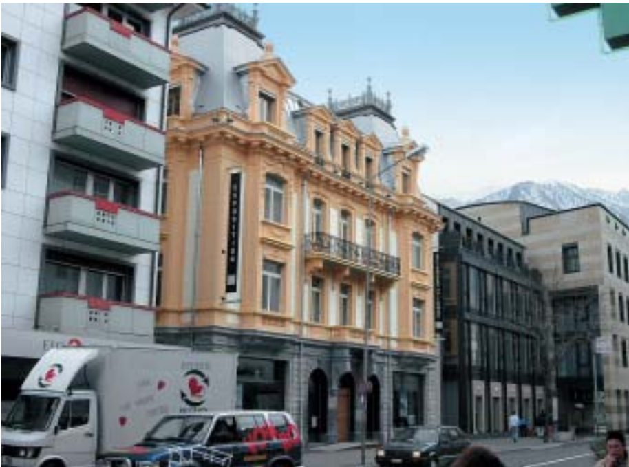
3. Rang. Durch die Sanierung unter Berücksichtigung der ursprünglichen, intensiven Farbgebung erhält das Gebäude wieder eine prägende Dominanz im Strassenzug
