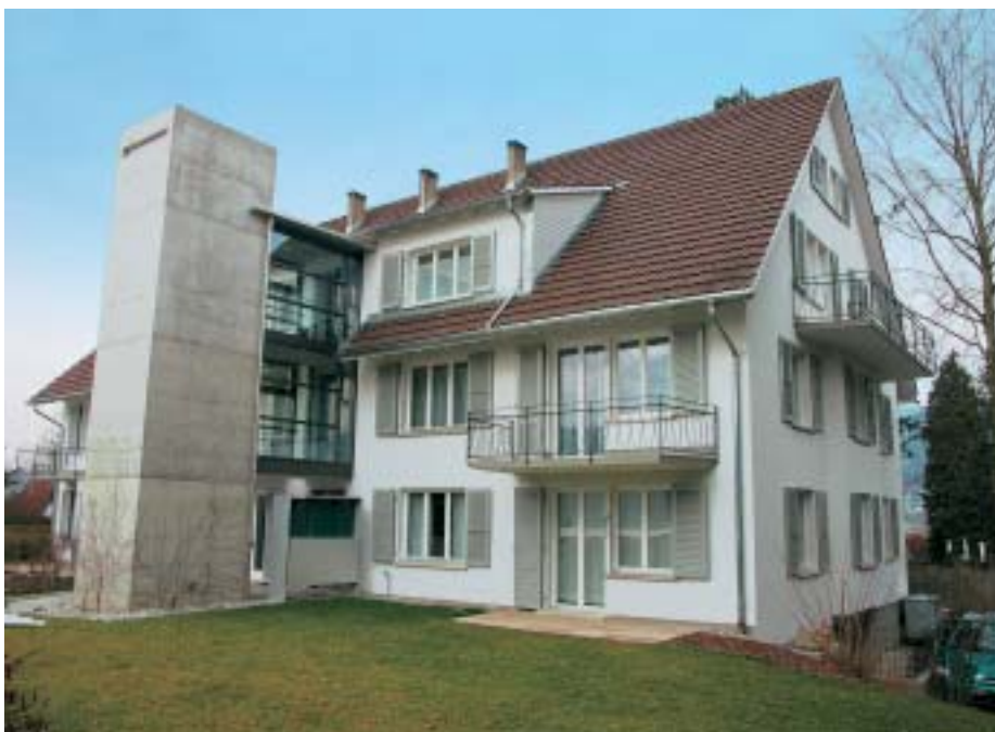
2. Rang. Das neue Farbkonzept lehnt sich an das ursprüngliche an, berücksichtigt aber die neue Nutzung als Ergänzung zum Spital
