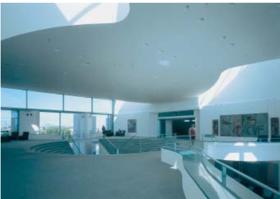
Ein Beispiel für eine hochwertige, geglättete Putzdecke findet sich im Bundeskanzleramt
