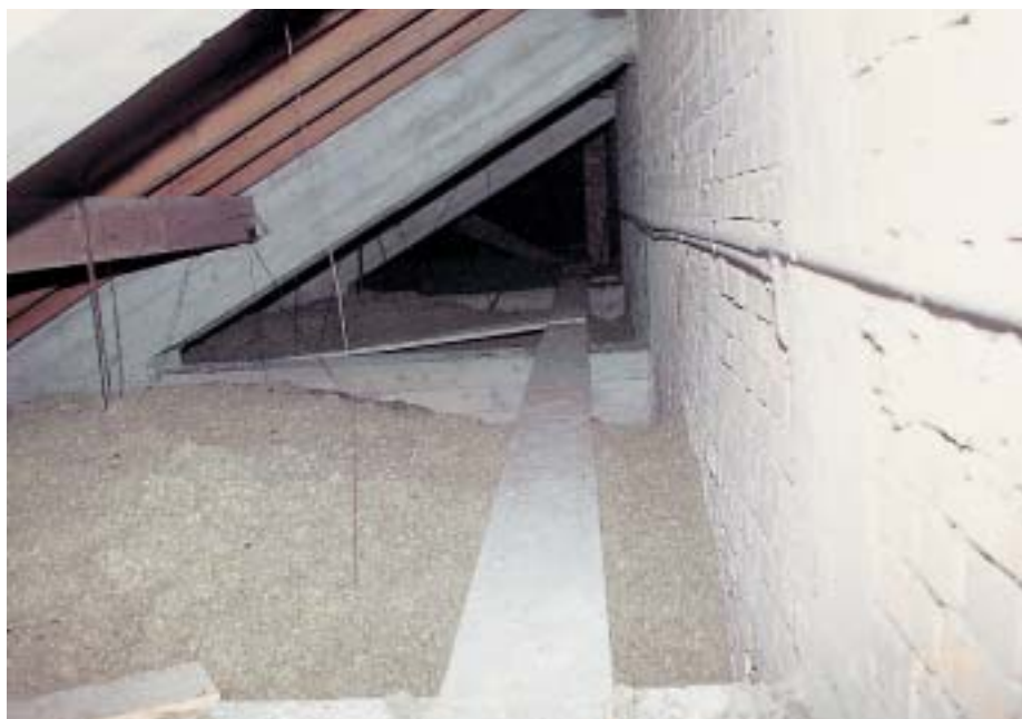
Dachraum über Seitenschiff mit teilweise freiliegenden Betonträgern
