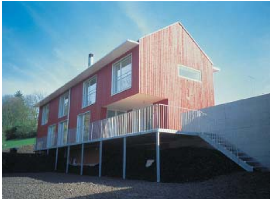
Einfamilienhaus in Oberembrach. Form gewordene Farbe zu bauen, war das zentrale Anliegen der Gestalter. Das Haus steht auf einer Krete, und seine Farbe verändert sich daher besonders stark mit den Jahreszeiten und dem Wetter. Architektur: Leo Frei Architekten. Farbgestaltung: Beat Soller und Joe Studer, Max Schweizer AG, Zürich
