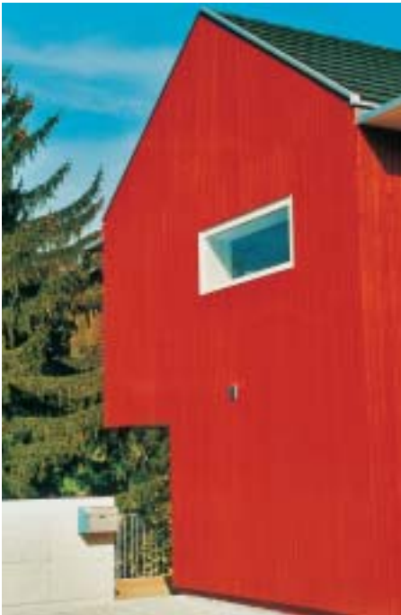
Einfamilienhaus in Oberembrach. Detail der roten, direkt in den Boden stossenden Fassade. Architektur: Leo Frei Architekten. Farbgestaltung: Beat Soller und Joe Studer, Max Schweizer AG, Zürich
