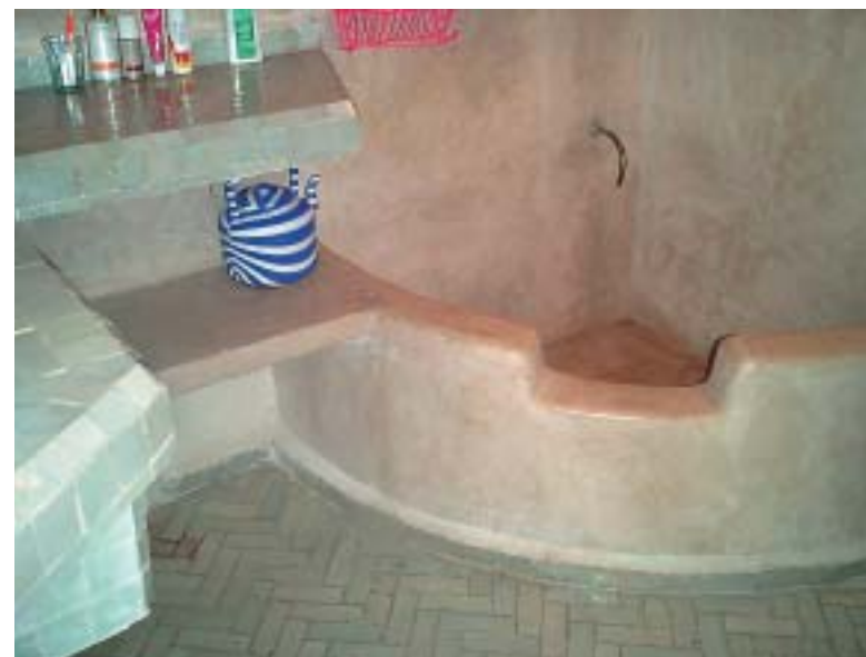
Nicht nur Fussduschen können in Tadelakt ausgeführt werden
