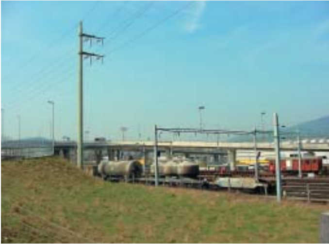
Bild 6 und 7 Betonbrücken in Delémont mit Silikon-Mikroemulsionen hydrophobiert
