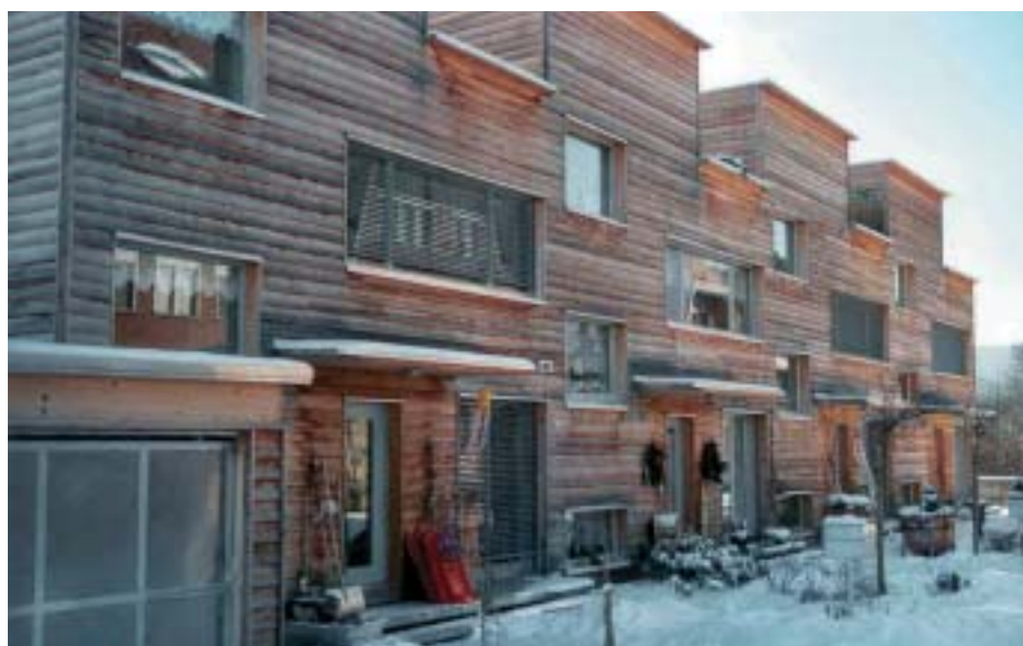
Bild 3: Unbehandelte, vergraute Holzfassaden etwa drei Jahre nach Bauabnahme
