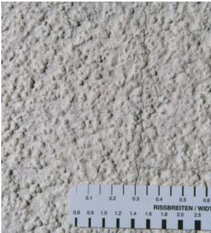
Bild 4 und Bild 5: Rissbreite: 0,05 bis 0,3 mm. Die darunter liegenden Fugen sind bis 10x breiter
