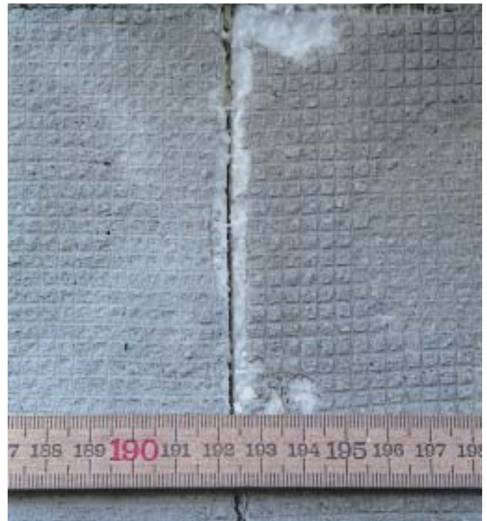
Bild 4 und Bild 5: Rissbreite: 0,05 bis 0,3 mm. Die darunter liegenden Fugen sind bis 10x breiter
