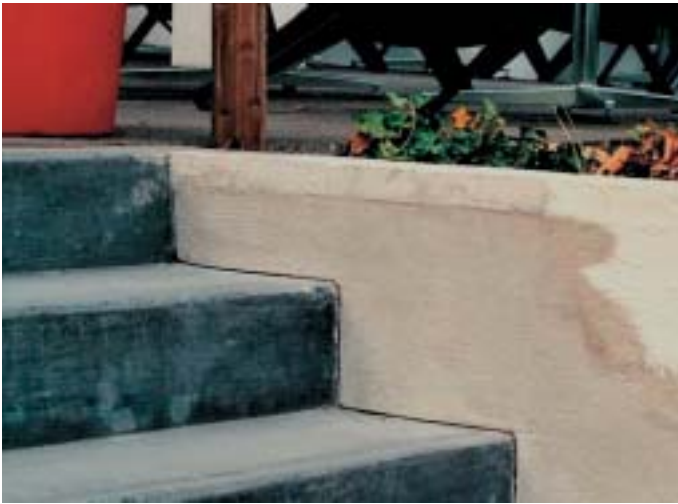
Bild 5: Der Sockelgrundputz wurde aufgetragen und durch einen Trennschnitt von den Treppentritten getrennt. Nach dem Anstrich wird ein ca. 50 cm breiter Streifen der Wand hydrophobiert
