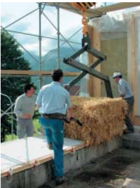
Wandaufbau mit Strohballen
