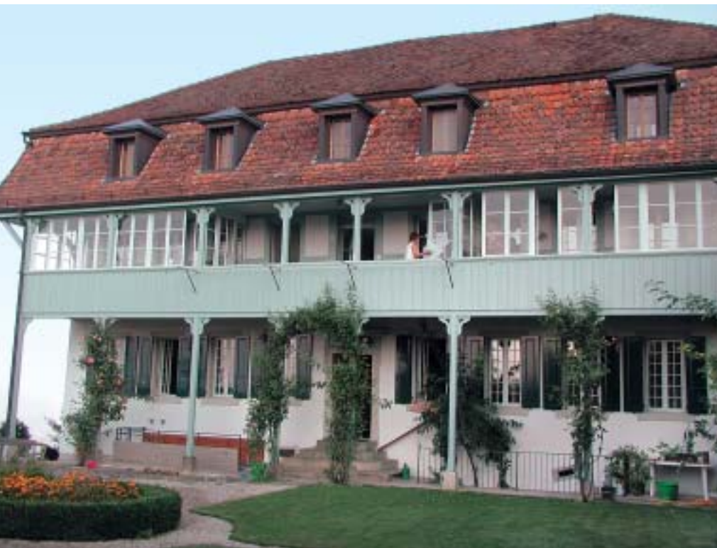
Altes Restaurant, zu Wohnungen umgebaut. Ballenbühl bei Gysenstein BE
