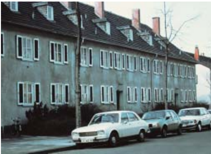
Bild 5: Verschmutzter Fassadenanstrich 1969; Bildaufnahme 1982 – mit Dispersion der 2. Generation
