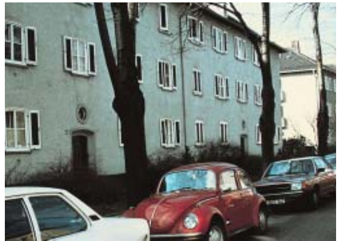
Bild 6: In der gleichen Strasse: Sauberer Fassadenanstrich 1969; Bildaufnahme 1982 – mit Dispersion der 3. Generation
