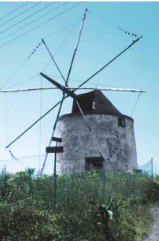
Bild 1: Abgewitteter Kalkanstrich auf einer Windmühle in Portugal
