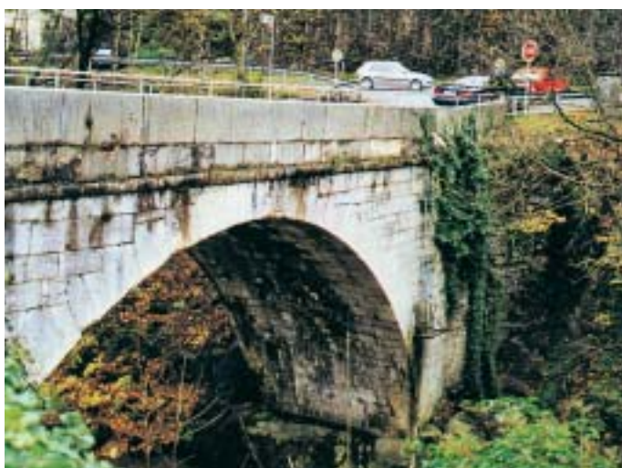
5/6 Restaurierung der Birsbrücke in Angenstein BL. Hier wurde ein Spezialbeton mit Hochofenzement verwendet, um die Bildung von Ausblühungen im Kalksteinmauerwerk möglichst gering zu halten
