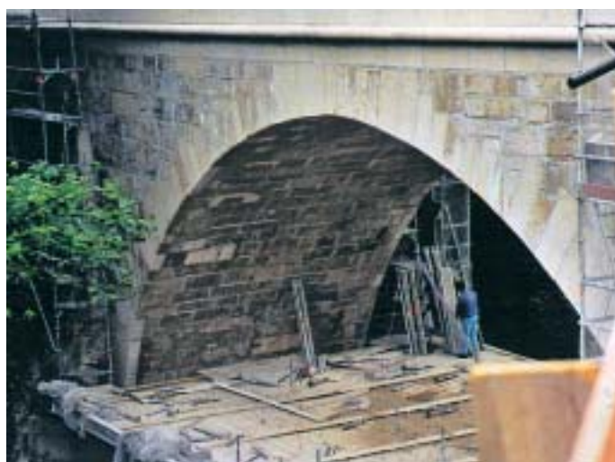
5/6 Restaurierung der Birsbrücke in Angenstein BL. Hier wurde ein Spezialbeton mit Hochofenzement verwendet, um die Bildung von Ausblühungen im Kalksteinmauerwerk möglichst gering zu halten
